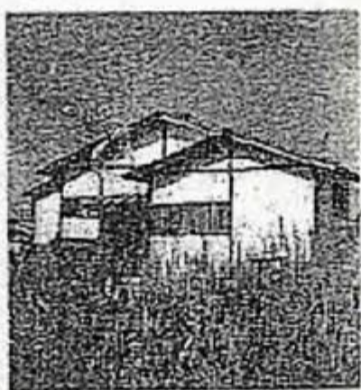
父が建てた白壁の小屋
